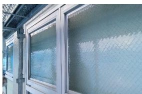
上部排煙窓ペアガラス化
